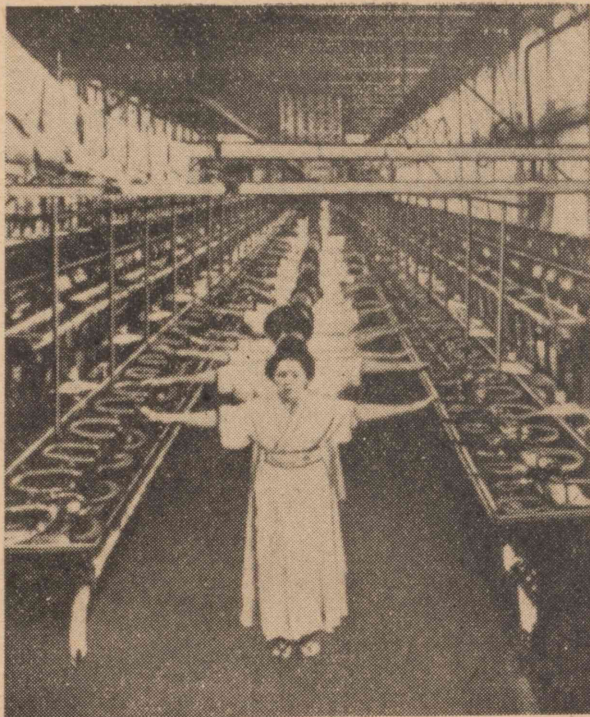
製糸工場内部
