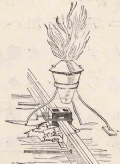
第79圖 テルミットにてレールの熔接。
