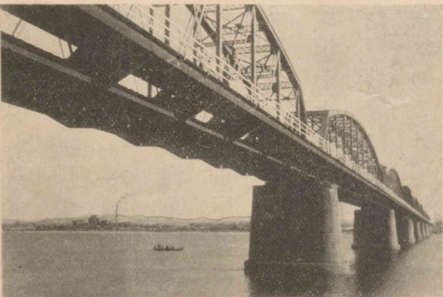
鴨綠江の鐵橋
