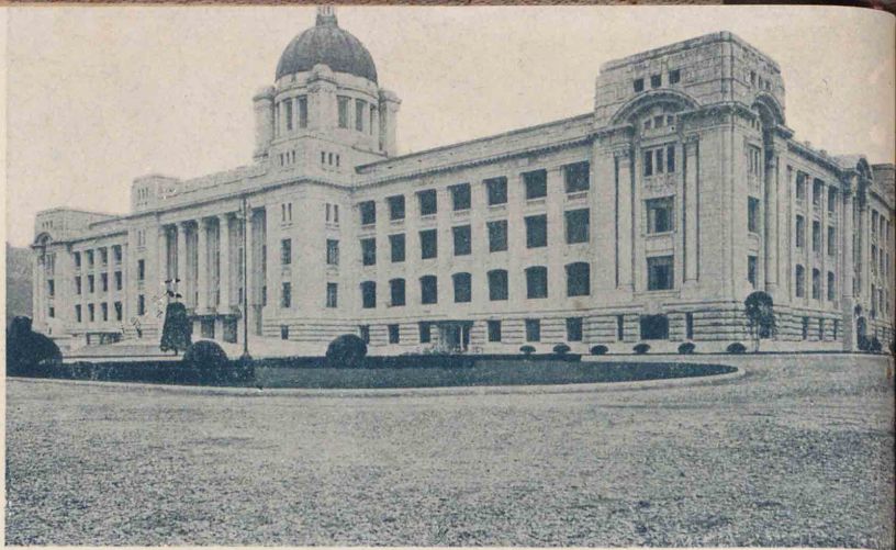
朝鮮總督府 半島の統治の中樞として營まれた五階建鐵筋コンクリート造で數十種の大理石を配り詰め宏壯美麗で中央塔の高さは約五十四米ある
