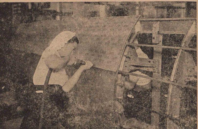
今日も一日、エヤーハンマーをしつかり握つて、何百となく、何千となく鉄を打ち込んだ。この鉄は、爆撃機の胴體下面覆ひを作るためには打ち込むのだ。打ち込み方が悪くて、繼き合はせたジュラルミンの部分品が、空中分解でもしたらどうする。一つの鉄でも、おろそかに打つことはできない。「しつかり頼みますよ」と祈る私の心に答へるやうに、ジュラルミン板は凄い響きを立てる。今日は、おかげで一本の鉄もしくじらなかつた。
