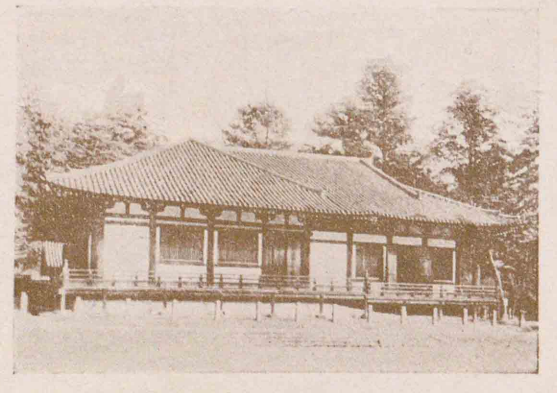
日唐招提寺金堂 唐僧鑑眞の創建にかゝるもの、堂の正面一間通りを吹き放しにして、柱ばかりを列べてあり、やゝそりのある屋根は石壇と對して力強い美しさが見られる。
