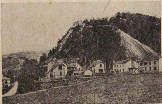
カンタールの發電所
