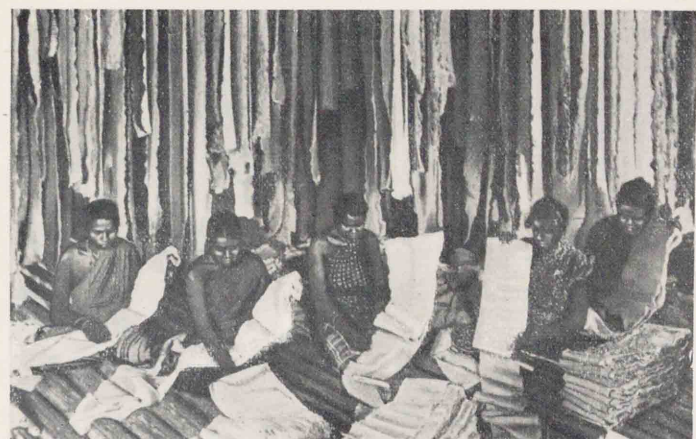
ゴムの乾燥 造上げたゴムをローラにかけ板状にしたものを乾燥室に吊した光景
