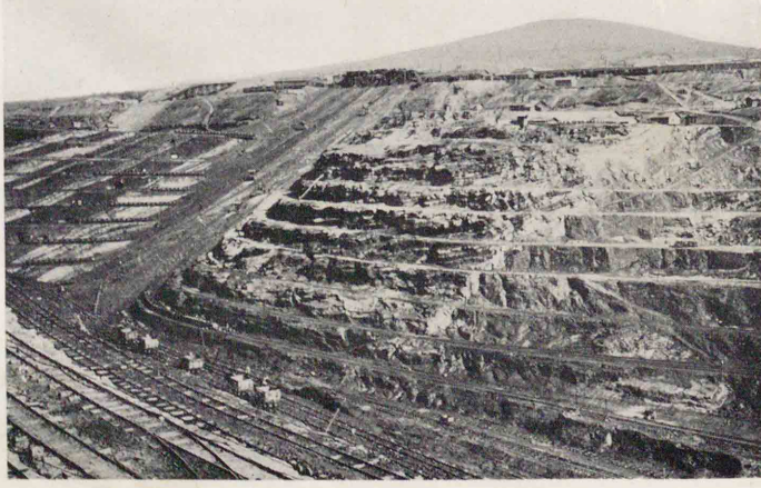
撫順炭田の露天掘 階段狀に掘下げられ多數の運炭車が右に左に絶間もなく通つてゐる
