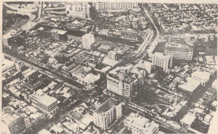
都市の垂直的發達の一例 (東京日本橋附近)
