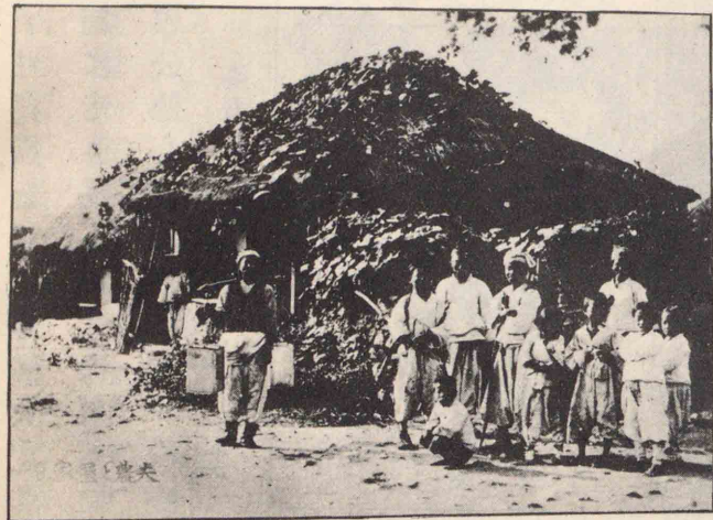
朝鮮民族 大和民族よりは身長が高い。衣服には白地が多く用ゐられるので女は洗濯に忙がしい。食物は米を主食とし又麥・粟等を用ゐる。家屋は木造の平屋建て、外壁は土と石とを混じて塗つたものが多い。冬季には温突を用ゐて暖を探る。
