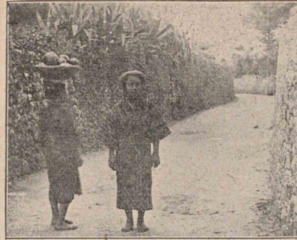
石垣島の防風垣 颱風の通路となる 同島では特殊施設を要する
