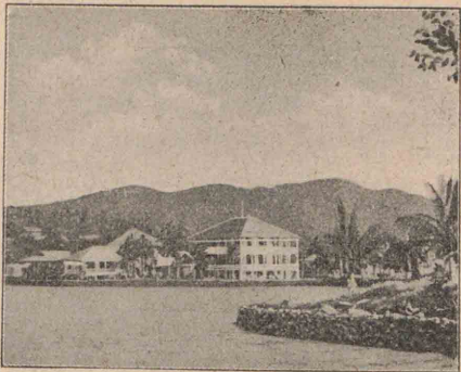
日・米・蘭海底電線中継所ヤツプ局
