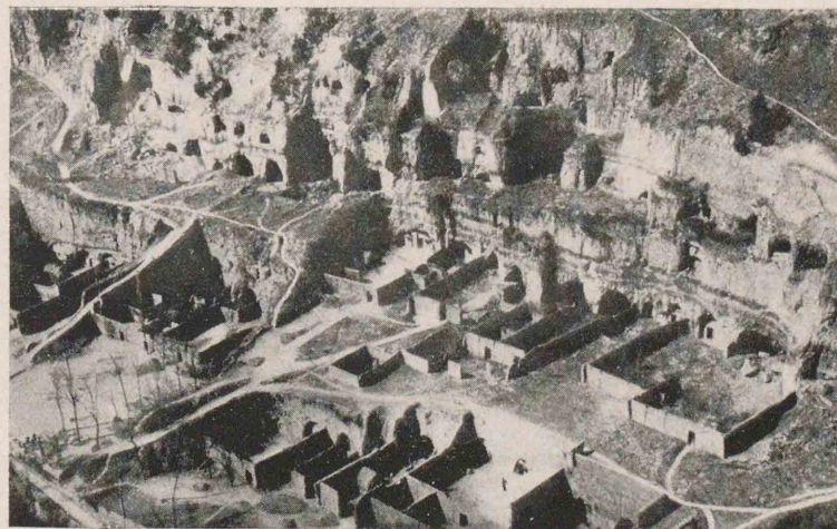
7 黃土地域の穴居の一型式(甘肅省), 斜面を切り崩して崖下に穴居家屋を造る, 前面の土の圍壁は夜間羊・牛等を保護するためである
