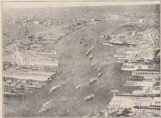
【圖解】フィラデルフィヤの埠頭（河の兩岸に船渠が楯比してある）
