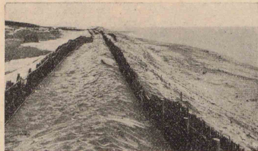
(新嘉坡市近郊) 海岸に於ける防砂工事
