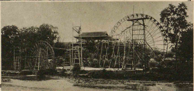
水車による漑漑 (支那四川省)
