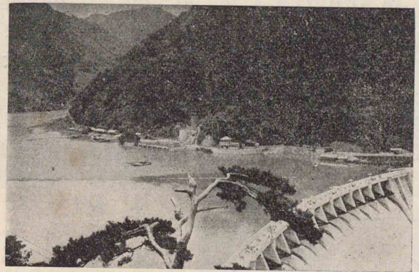
庄川発電所の堰堤
