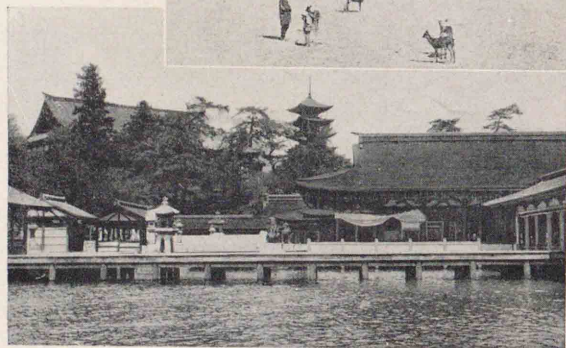
巖島は潮汐 潮汐の干満は海を見ない山國では奇異に感ずるが一は満潮時で廻廊が全く水上に浮び一は干潮時で同じ場所に神鹿が遊んでゐる
