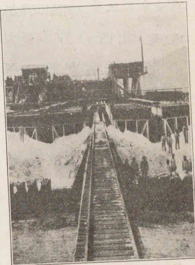
硝石の精製 鑛石を碎いて熱湯に溶解し更に結晶せしめて製する
