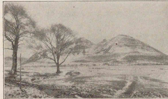
大孤山 鞍山製鐵所の原鐵採掘所で鉄巻き段に山を切り採つてゐる、貧礦である
