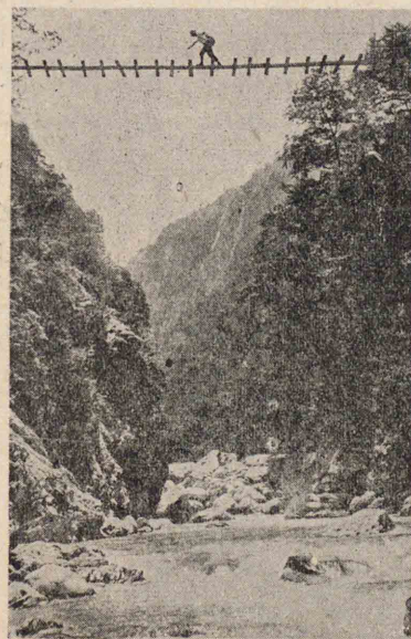
黒部峡谷奥鐘吊橋
