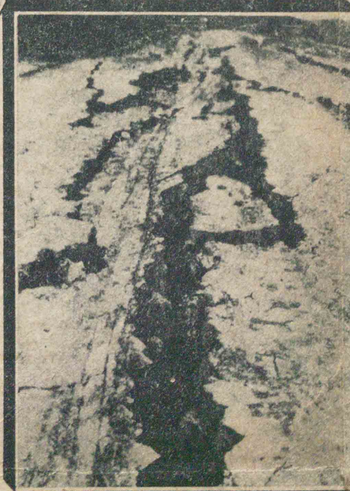
地震による大龜裂
