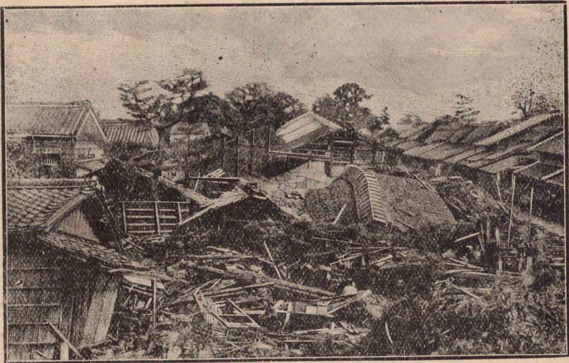
明治二十四年尾濃地震の時の清洲町の震害
