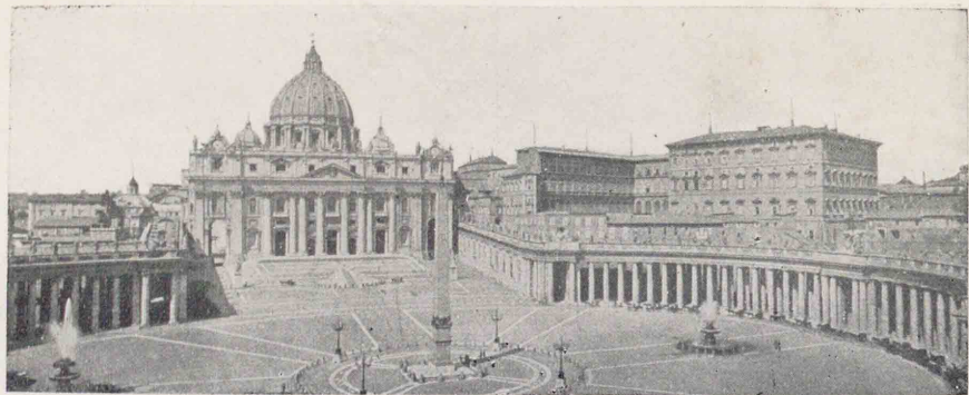
(利太伊) 院寺ーターペトンセ (築建スンサッネル)
