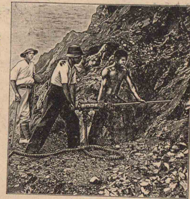
第92圖：碎岩機の使用
