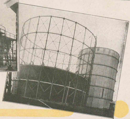
← ガス洗滌機 → ガス溜(左・有水式 右・無水式)
