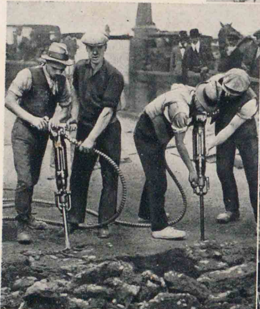
↑ 穿孔機 (道路を破壊してゐるところ)
