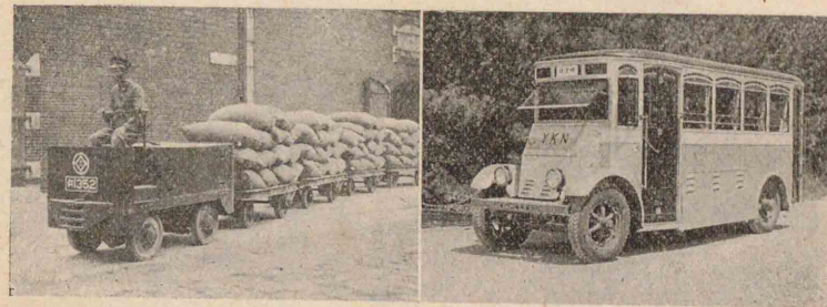
(圖293) 蓄電池を使用した電氣車と電氣自動車
