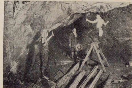
第4圖 坑内の手掘作業
