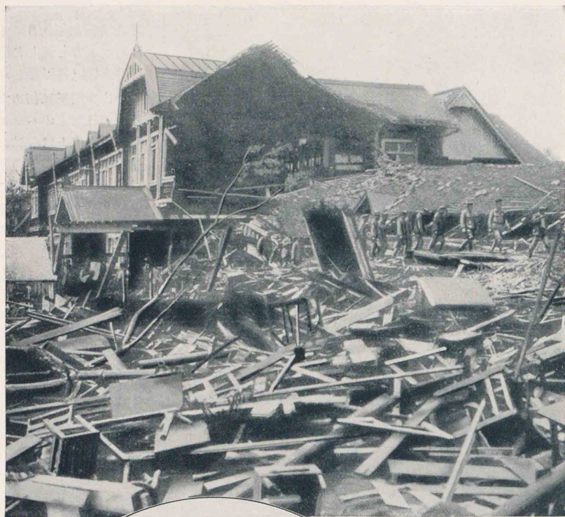
圖は昭和九年の室戸 颱風による大阪市内 に於ける被害の有様 である。風速は通常 20分間の平均の速 さで示すが、それで 毎秒30米位になると 大きな樹も倒れ初め 人は歩行が困難であ るのに、この時室戸 では毎秒45米、徳島 では37米、大阪では 31米であつた。被害 の甚だしかつたのも 想像できよう。(下圖 は氣壓を自動的に精 密に測る自記氣壓計)
