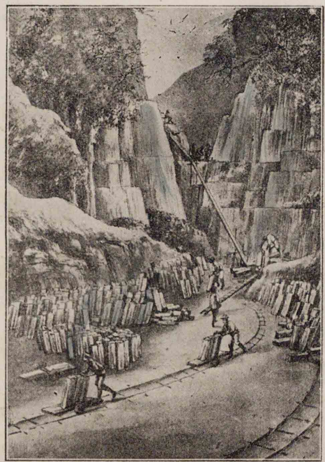
圖解 安山岩の一種なる鐵平石採掘
